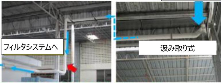
2) 雨水取水をフィルタシステムへ (3段階フィルタ)
