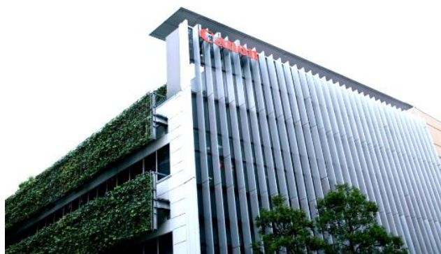
東京本社外壁
