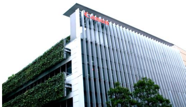
東京本社外壁
