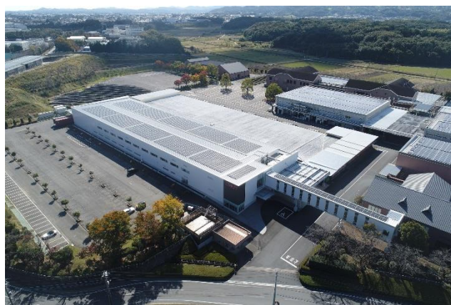
2022年9月建設の新棟(中央)
