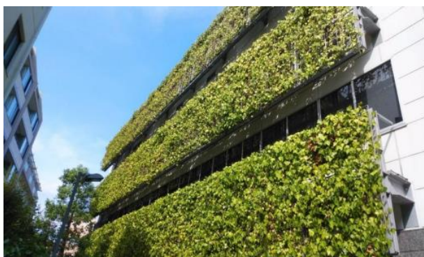
東京本社外壁
