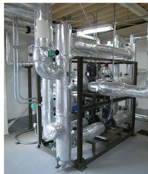
地下温泉を利用した空調システム （プレート式熱交換器）
