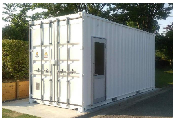
2024年7月に新設された鉛蓄電システム
